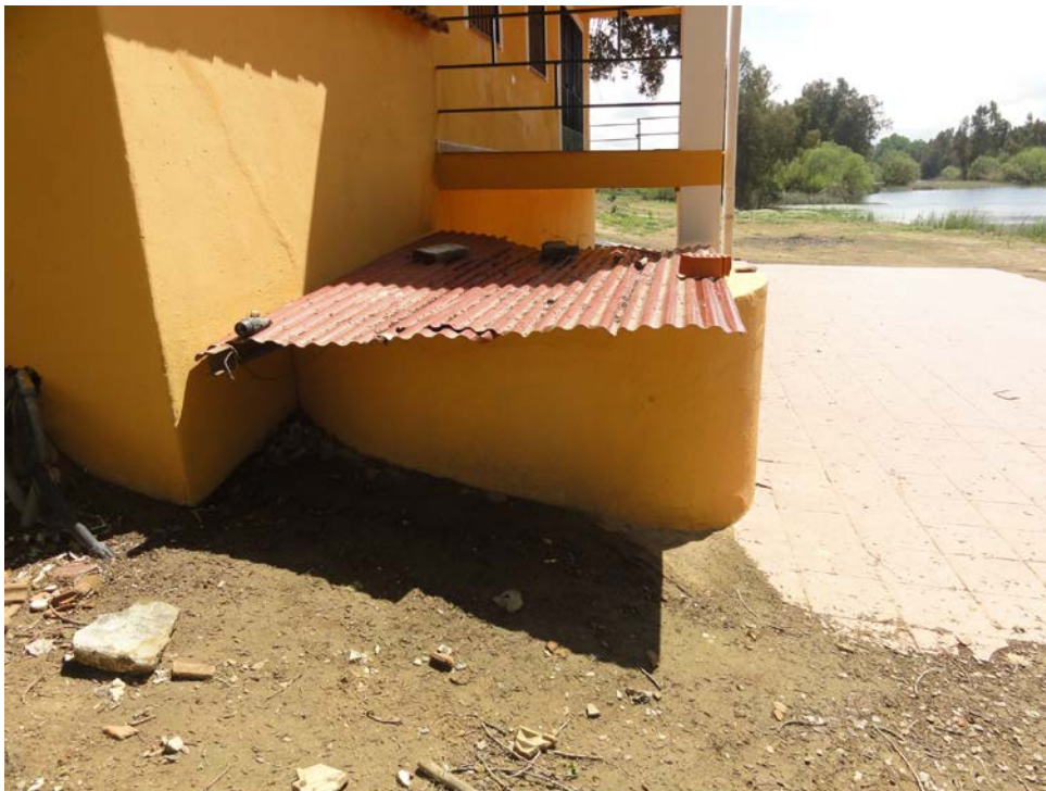
Foto 2. Pozo donde se aloja el bombeo
